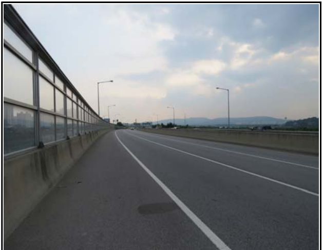
내 용 교면포장 전경
