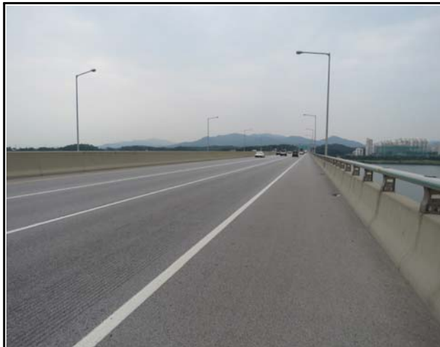
내 용 교면포장 전경
