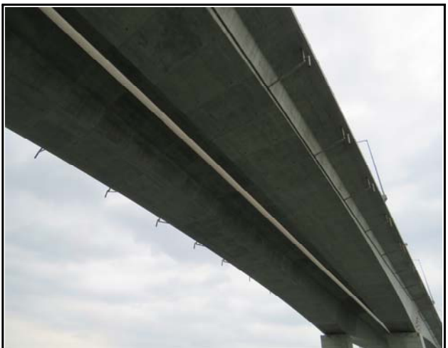
내 용 교량하면 전경
