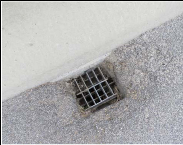
내 용 S8 배수구 상태양호
