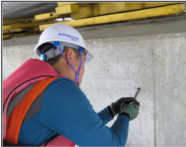
내 용 P7 탄산화 깊이 측정
