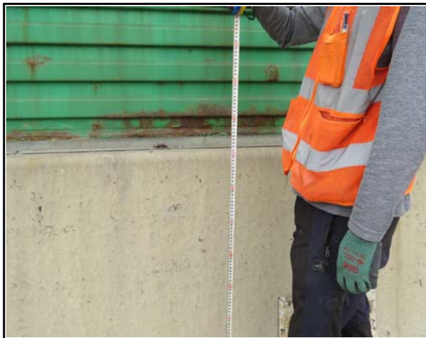
내 용 방호벽 제원조사
