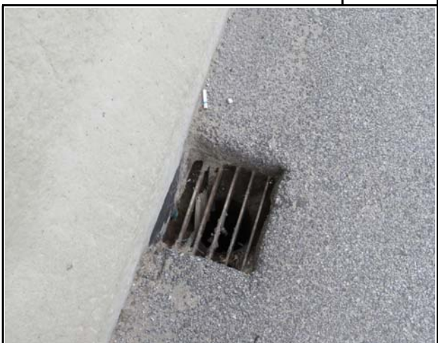
내 용 S15 배수구 상태양호
